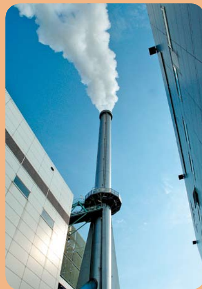
La vapeur d'eau condensée rend visible le panache de fumée en sortie de cheminée.
