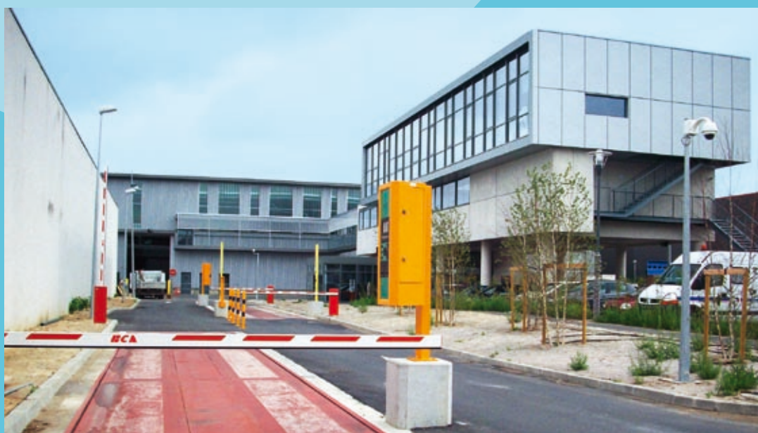
Vue du centre de tri depuis la rue Henri-Becquerel
