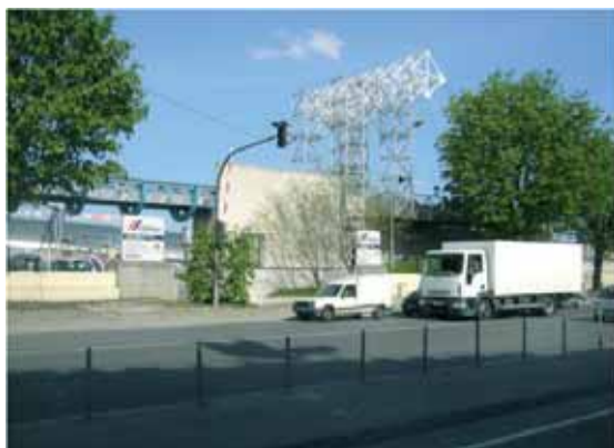
Ivry, quai Marcel-Boyer : mur anti-crue et espace public à requalifier
