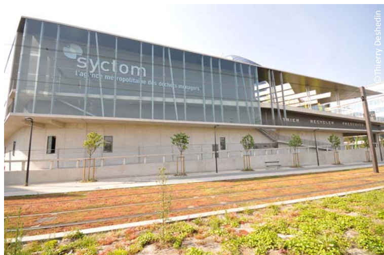
Le centre de tri, vu du côté du tramway
