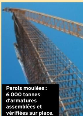
Parois moulées : 6 000 tonnes d'armatures assemblées et vérifiées sur place.
