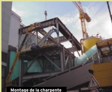
Montage de la charpente de l'électrofiltre complémentaire de la ligne 1 (en aval de l'électrofiltre existant).
