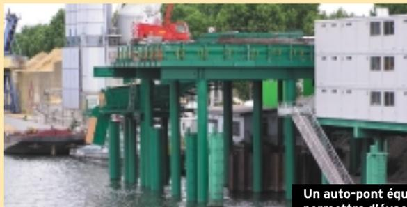
Un auto-pont équipé d'un mur antibruit et antipoussières, permettra d'évacuer les terrassements par voie fluviale et d'acheminer les gros équipements du centre.
