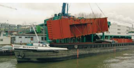
Les fours-chaudière d'Isséane ont été acheminés par voie fluviale depuis la Croatie.
