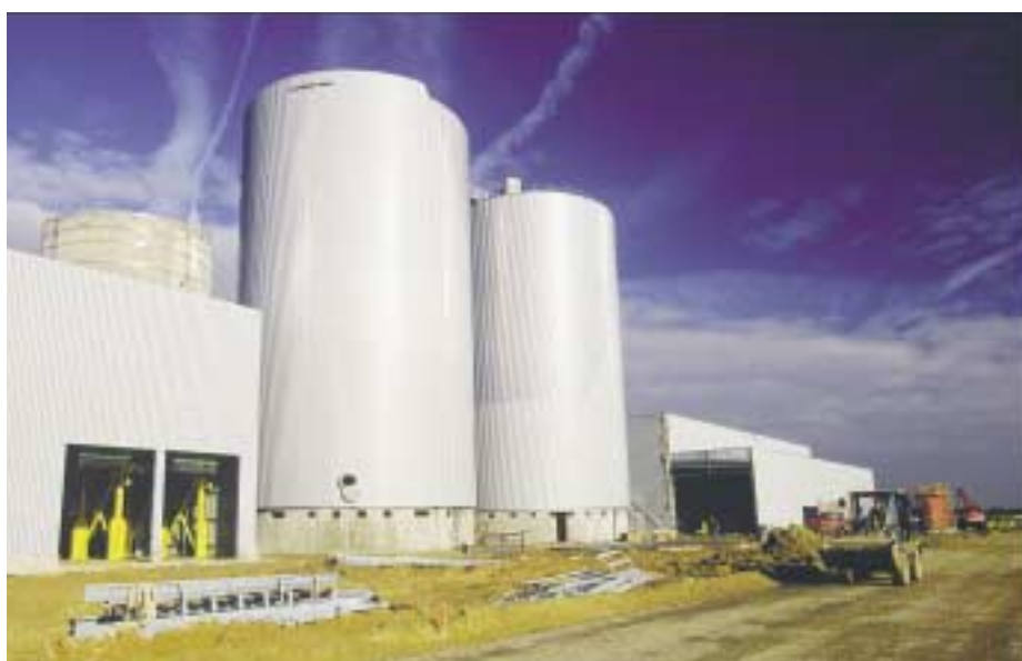
The Varenne-Jarcy methanisation plant. Digesters.
