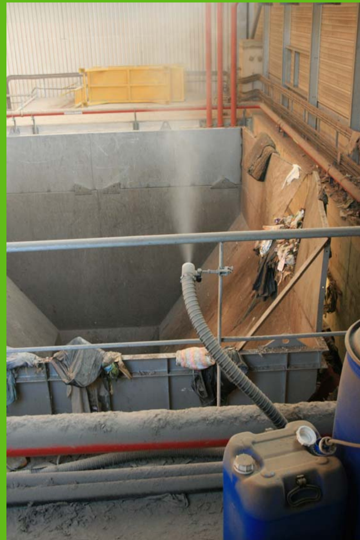
niveau fosse et trémie de rechargement
