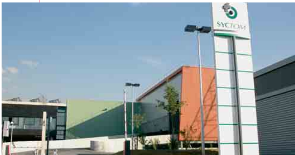
Le centre de tri à Nanterre a démarré son activité en juin 2004.
