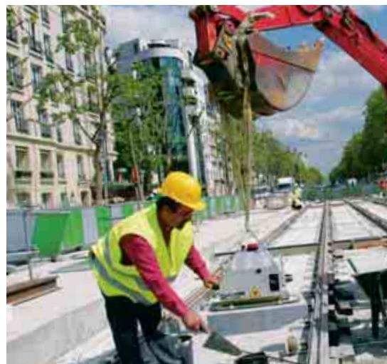
Les mâchefers issus du centre multifilières d'Ivry-Paris XIII sont utilisés pour la construction des voies du tramway à Paris.
