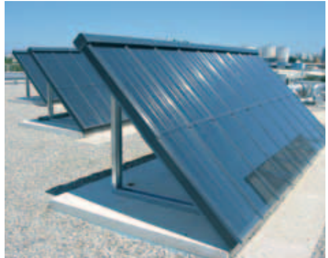
Les panneaux solaires installés sur le toit du centre de tri à Nanterre couvrent la moitié des besoins en eau chaude sanitaire.
