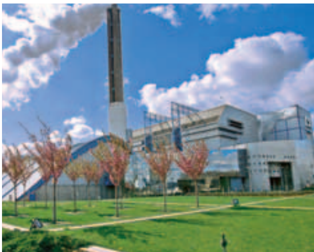
Le centre d'incinération avec valorisation énergétique à Saint-Ouen a fait l'objet en 2005 de travaux de modernisation du système de traitement des fumées.
