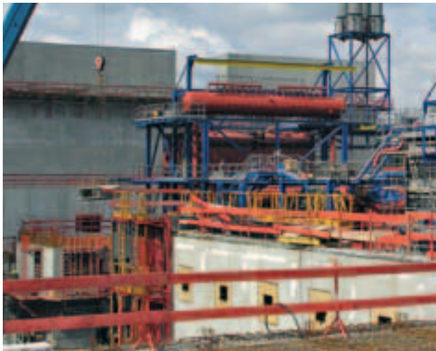
Le chantier du futur centre Isséane, dont la mise en service est prévue en juillet 2007.
