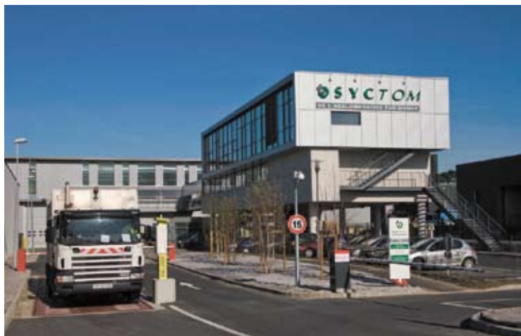
Le SYCTOM a investi 13,8 millions € dans le centre de tri des collectes sélectives à Sevran.
