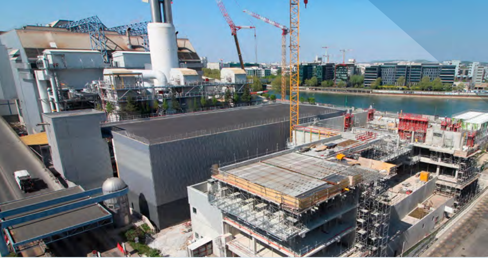
Travaux de modernisation du centre à Saint-Ouen-sur-Seine pour l'amélioration des performances et l'intégration urbaine.
