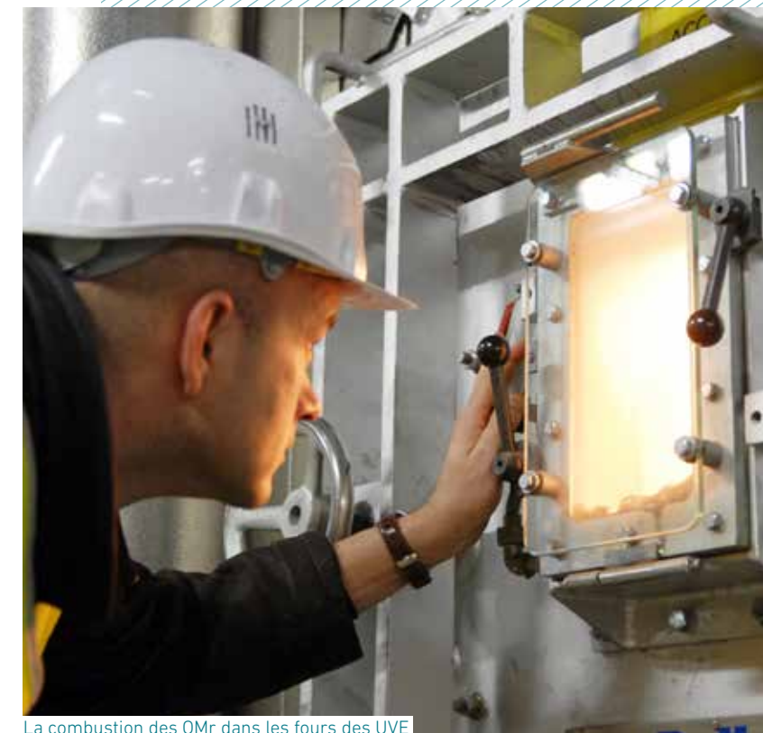
La combustion des OMr dans les fours des UVE permet de produire de l'énergie.
