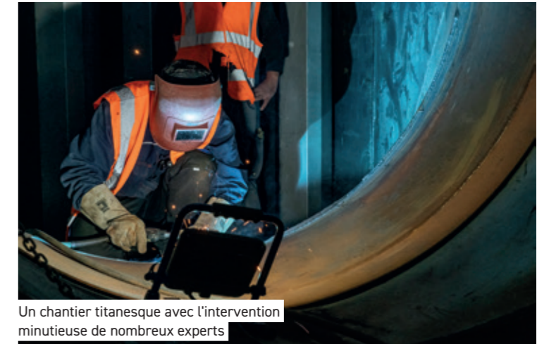
Le montage de l'ouvrage de la cheminée, composé d'une structure métallique de plus de 1000 tonnes, s'est achevé à l'été 2023
