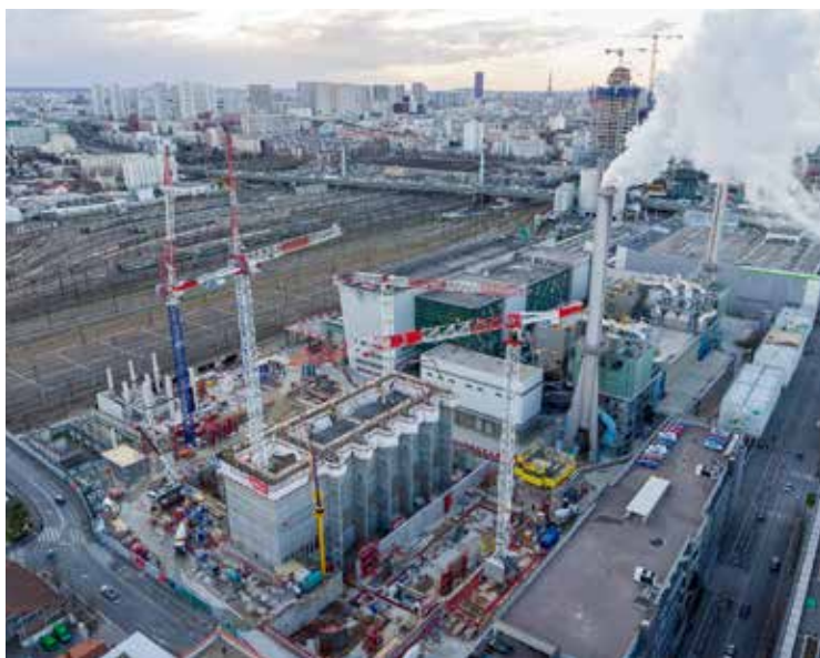
Vue aérienne du chantier à Ivry/Paris XIII
