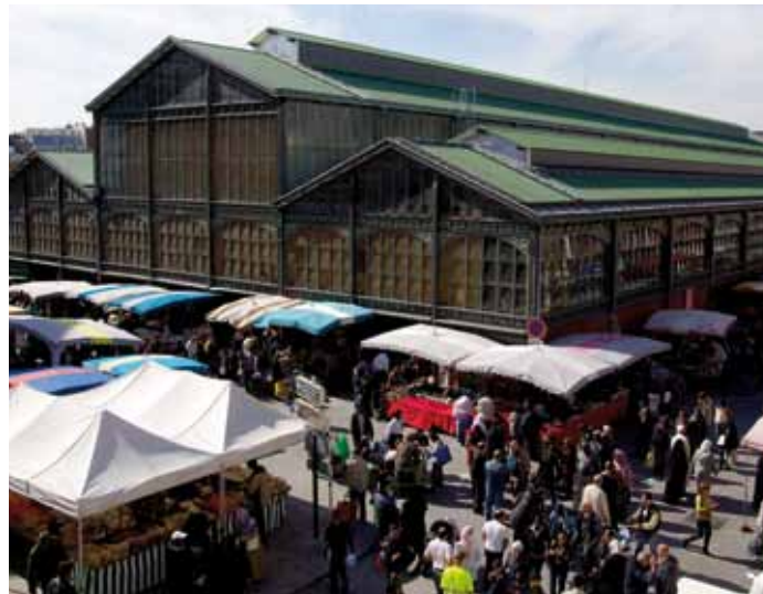
Entièrement rénovée, la halle du marché est recouverte de 240 m 2 de panneaux photovoltaïques et équipée d'un système de récupération des eaux de pluie qui sert au nettoyage de la voirie.
