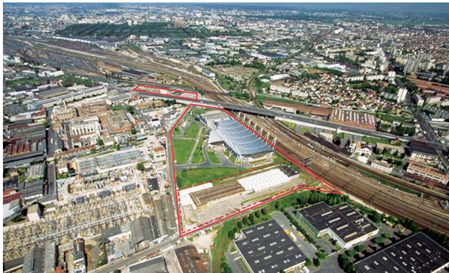
Le site de Romainville s'agrandit pour accueillir vers 2010 une unité de méthanisation. En s'orientant vers ce procédé, le SYCTOM diversifie ses modes de traitement et améliore le taux de valorisation des ordures ménagères.
