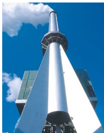
Le SYCTOM prévoit la suppression du panache des fumées et l'intégration architecturale des cheminées.
