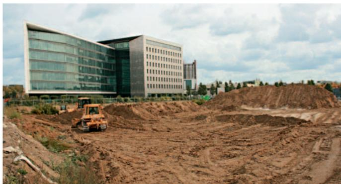
La première étape des travaux consiste à remblayer le terrain d'une surface de 11 000 m<sup>2</sup>.
