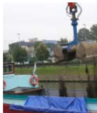
Pour éviter le trafic des camions, les ferrailles sont convoyées par péniches.
