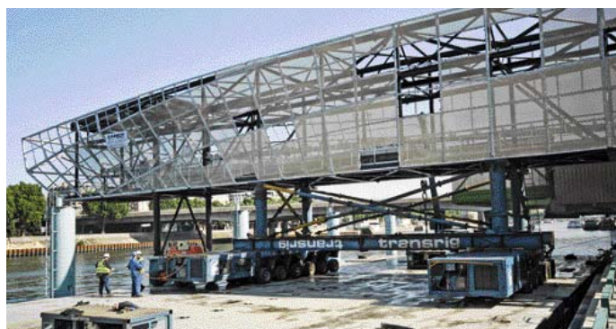
L'installation de la passerelle fluviale d'Isséane sur la Seine a eu lieu en juillet dernier.
