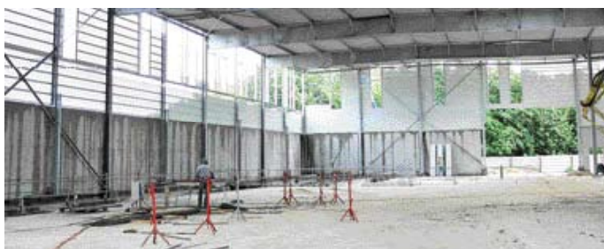
Un bâtiment conçu pour limiter les nuisances pour les riverains.
