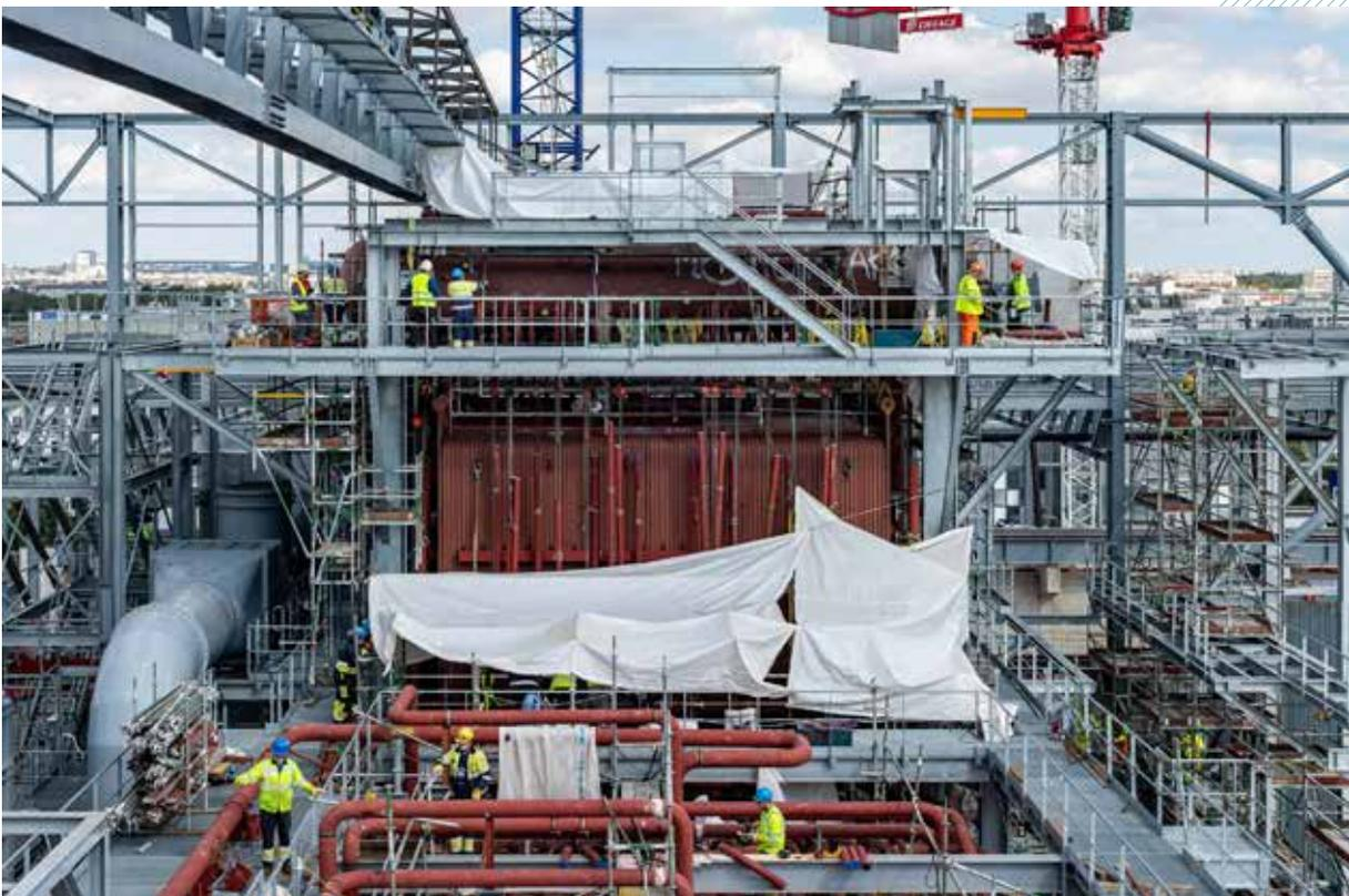
Montage de la chaudière de la première ligne de traitement, avec une capacité de production de vapeur surchauffée de 92 tonnes/heure. 4 700 soudures ont été nécessaires pour assembler tous les éléments et tuyauteries.
