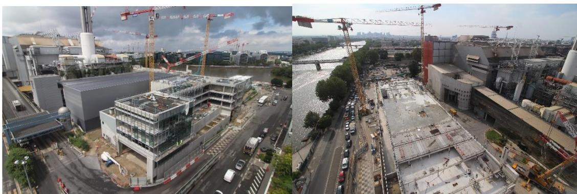
Les travaux de changement des parements de façades des bâtiments existants notamment du bâtiment habitant la fosse OM se poursuivent. Deux des piles porteuses du futur convoyeur des mâchefers au-dessus de la RD1 (système de rechargement fluvial des mâchefers) ont été réalisées. La pile coté Seine (estacade) est en cours de réalisation.
