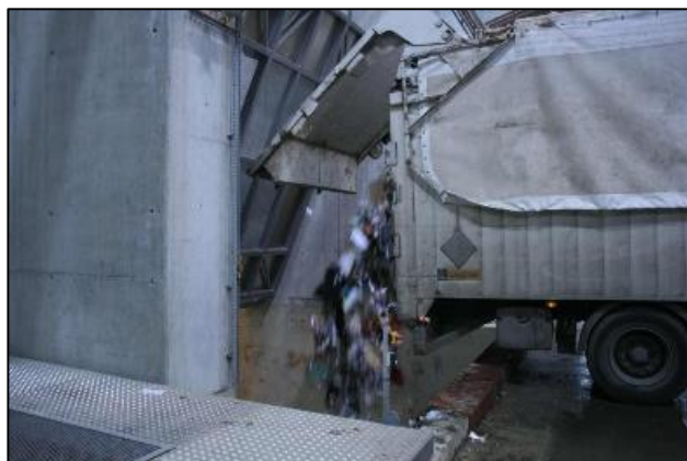
Figure 10 : Déchargement d'ordures ménagères en fosse
