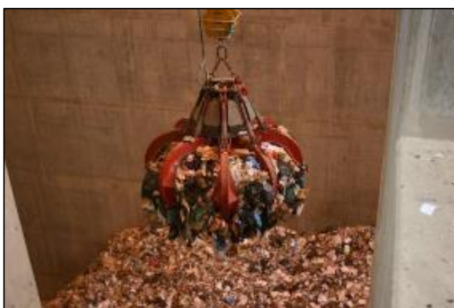
Figure 11 : Grappin sur pont-roulant en fosse
