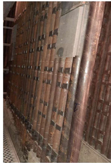
Photo 2: tubes remplacés sur un panneau après expertise
