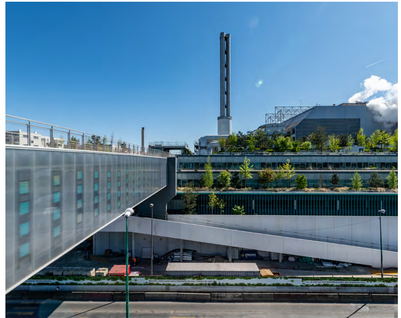
Après huit années de travaux, L'Étoile Verte offre de meilleures performances sur les plans énergétique et environnemental.
