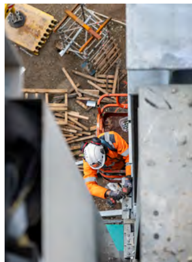
Des campagnes spécifiques sont menées en phase chantier pour surveiller la présence potentielle de polluants.
